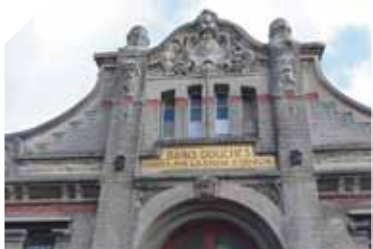
Façade des Bains-Douches © Ville d'Abbeville, AK
