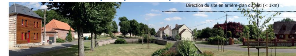
Figure 10 : Vue ouverte depuis le centre-bourg de Tilloy-lès-Conty, lecture du site étudié en arrière-plan du bâti, en particulier la partie ouest du site qui est la plus proche du bourg
