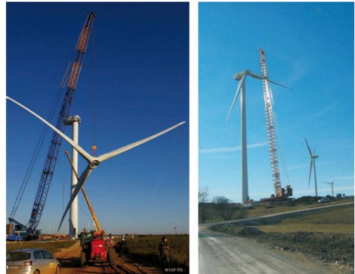
Figure 18 : Montage du rotor (à gauche) , montage pale par pale (à droite)
