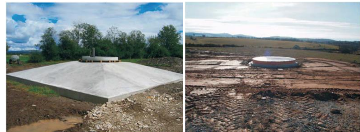
Figure 17 : Massif béton terminé (à gauche), état final après remblaiement (à droite)
