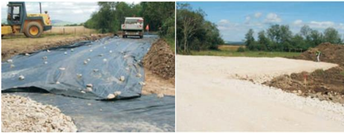
Figure 16 : Pose d'un géotextile de protection des sols (à gauche), état final d'une plate-forme (à droite)
