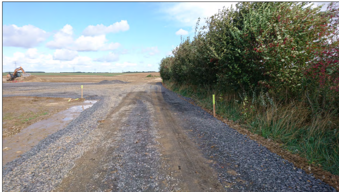
Photo 36 : Exemple de création de chemin d'accès
