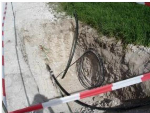
Figure 12 : Tranchée pour le passage des câbles électriques – Source : An Avel Braz
