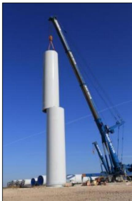
Figure 13 : Grues avant levage du moyeu
