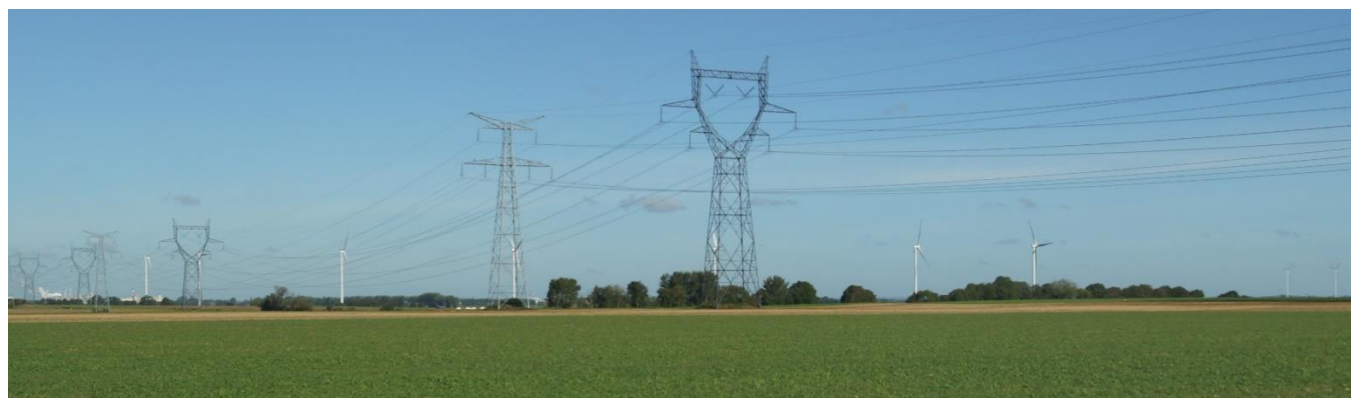
Photo 5 : ligne électrique THT et parc éolien au second plan à l'est de la ZIP
