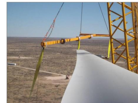
Figure 15 : Photos du chantier - assemblage des pales
