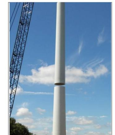
Figure 13 : Photos du chantier - assemblage de la tour
