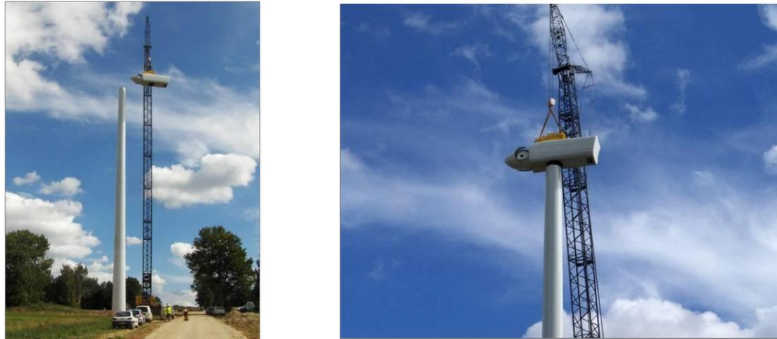
Figure 14 : Photos du chantier - assemblage de la nacelle
