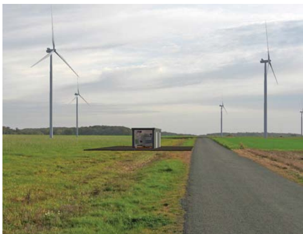
Poste de livraison utilisé comme support d'information sur le projet éolien
